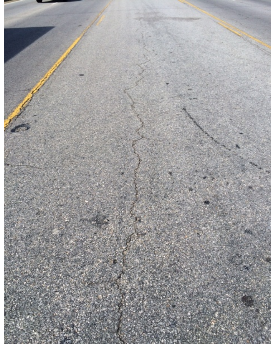
Longitudinal Cracking
